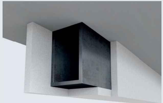
Belka o przekroju zamkniętym.
