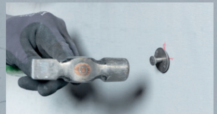
3 Befestigungsmittel einsetzen.
