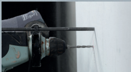
2 Löcher bohren.
