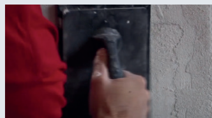
3 Puds kan påføres ca. 30 minutter efter påføring af Skamol Primer.
