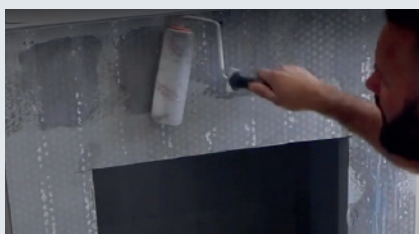
2 Påfør Skamol Primer på overfladen af SkamoEnclosure Board, hvor pudset skal påføres.
