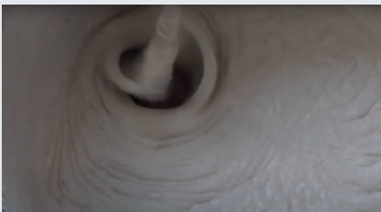
1 Bland puds med vand i henhold til det anførte blandingsforhold.
