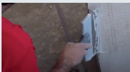
2 Påfør pudset, hvor der anvendes Skamol Corner.
