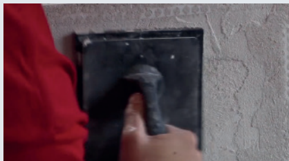
2 Påfør pudset i en jævn lagtykkelse.
