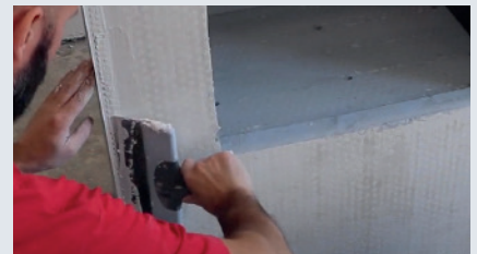
3 Jevn ut overflødig murpuss.
