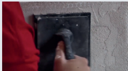
2 Omítku naneste ve stejnoměrně silné vrstvě.
