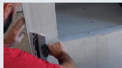
3 Přebytečnou omítku srovnejte.
