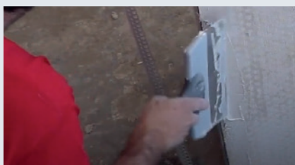
2 Omítku naneste na místo, kam připevníte chránič rohů Skamol Corner.
