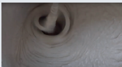
1 Смешайте штукатурку с водой в указанной пропорции.
