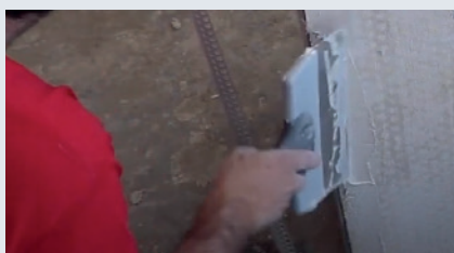
2 Нанесите штукатурку в тех местах, где будут использоваться угловые элементы Skamol Corner.
