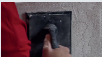
2 Нанесите штукатурку ровным по толщине слоем.
