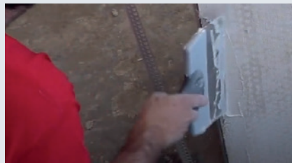
2 Tragen Sie den Putz dort auf, wo Skamol Corner verwendet wird.
