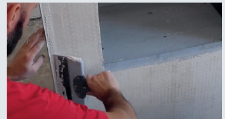
3 Überschüssigen Putz glattstreichen.
