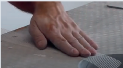
1 Bringen Sie Skamol Joint Tape auf.
