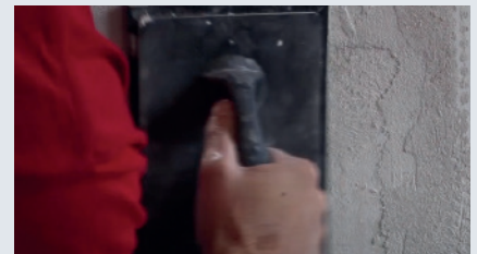
3 Der Putz kann etwa 30 Minuten nach dem Auftragen von Skamol Primer aufgetragen werden.
