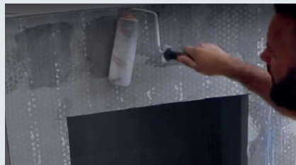
2 Tragen Sie Skamol Primer auf die Oberfläche des SkamoEnclosure Boards dort auf, wo der Putz aufgetragen werden soll.
