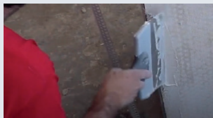
2 Appliquez l'enduit à l'endroit où le coin Skamol Corner est utilisé.
