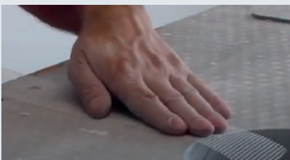
1 Mettez en place le ruban adhésif Skamol Joint Tape.
