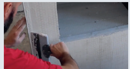
3 Nivelez l'excès d'enduit.
